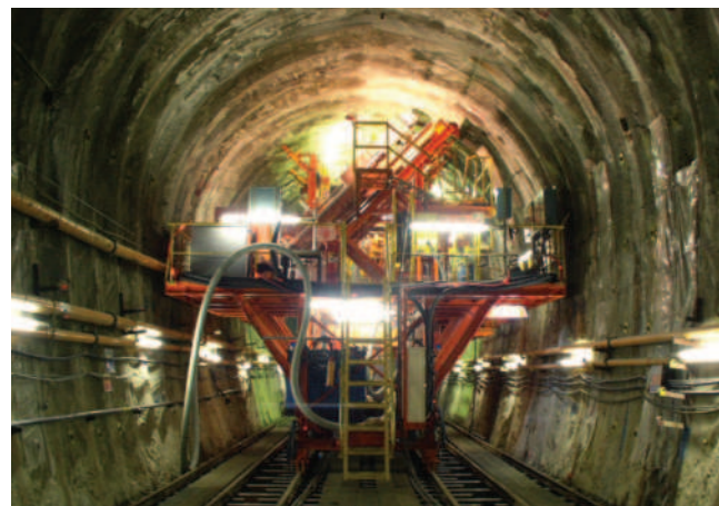
PSS工法専用架台 WAGON FOR PSS-SYSTEM
