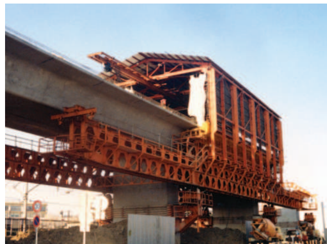
高架橋スラブ打設スライドセントル SLIDING FORM FOR OVERHEAD BRIDGE OR OVERPASS CONCRETE SLAB
