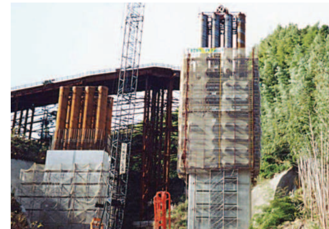
ピアー型枠施工用移動足場 MOVING SCAFFOLD FOR PIER FORM CONSTRUCTION
