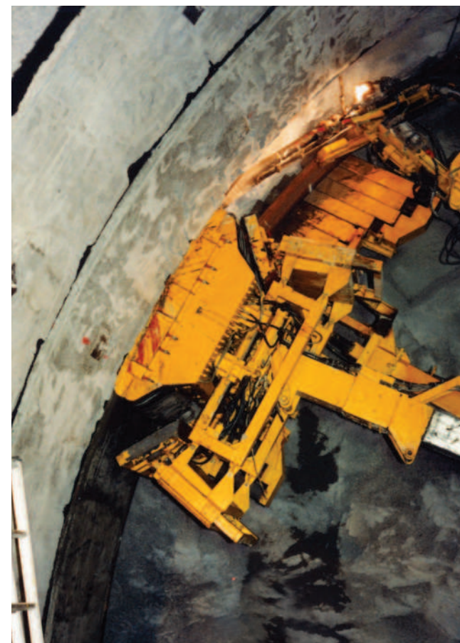
1次巻コンクリート覆工用圧着機【株式会社フジタ共同開発】（左：工場 右：現場） PRE-CAST LINING MACHINE FOR THE PRIMARY COVERING WORK
