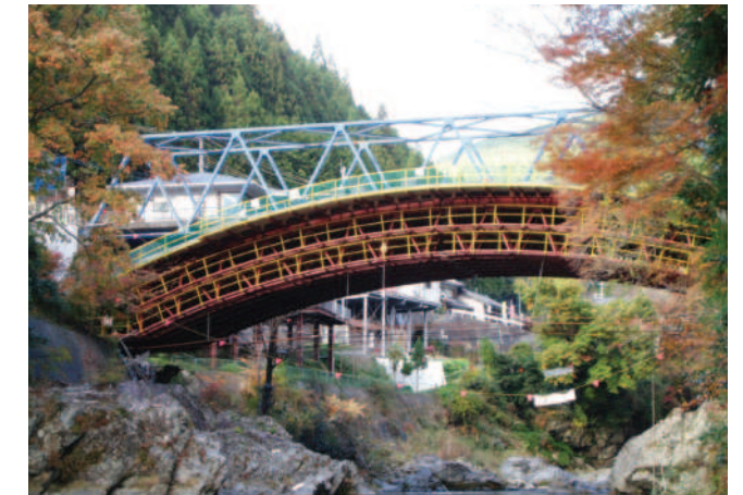
PC桁架設クレーン PC CONCRETE GIRDER INSTALL CRANE
