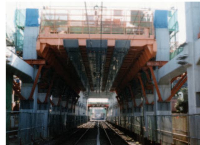
高架橋移動支保工 MOVING STEEL RIG FOR OVERHEAD BRIDGE
