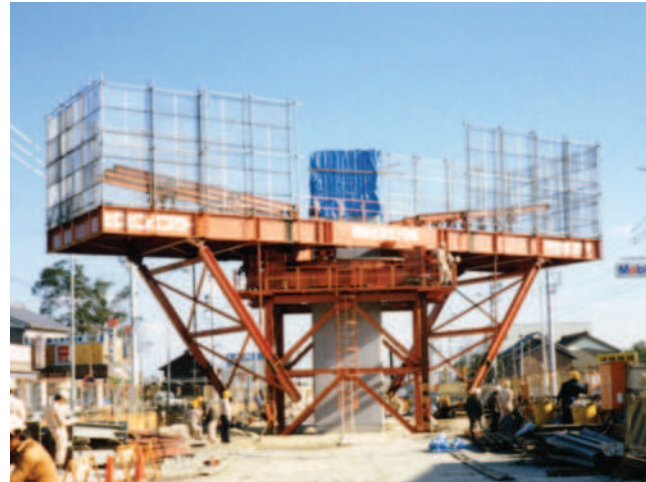
回転支保工 ROTATING STEEL RIG
