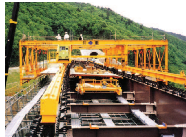
高架橋移動支保工 MOVING STEEL RIG FOR OVERHEAD BRIDGE
