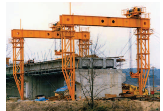
PC桁架設クレーン PC CONCRETE GIRDER INSTALL CRANE
