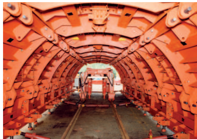
テレスコ内部 INSIDE TELESCOPIC CIRCULAR STEEL FORM
