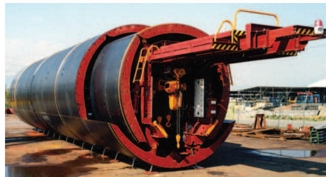
アーチフォーム移動 MOVEMENT OF ARCH FORM
