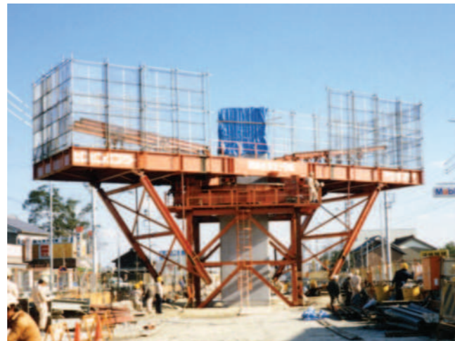
回転支保工 ROTATING STEEL RIG
