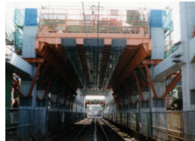
高架橋移動支保工 MOVING STEEL RIG FOR OVERHEAD BRIDGE
