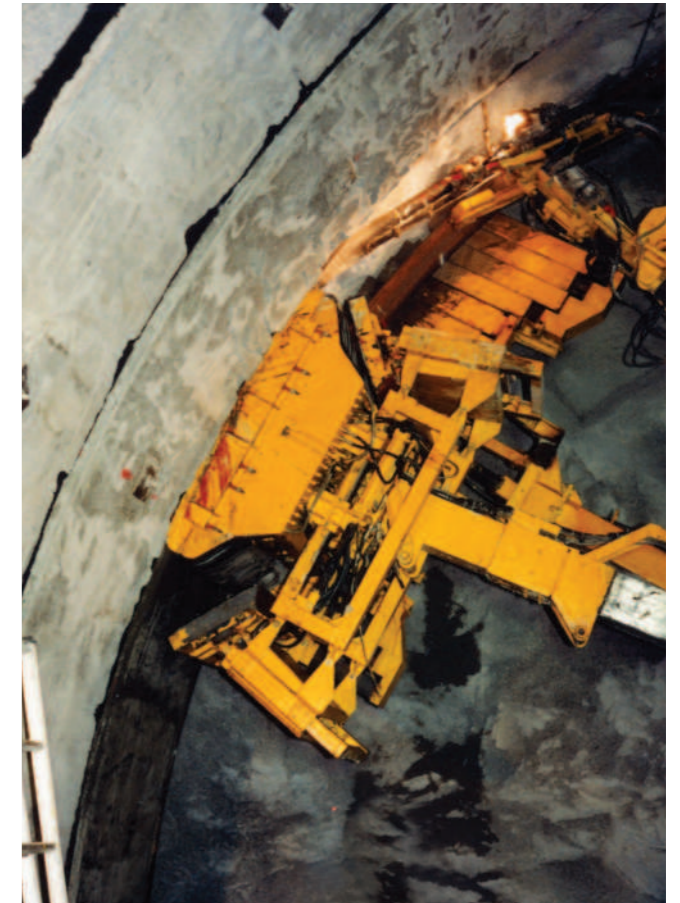
1次巻コンクリート覆工用圧着機【株式会社フジタ共同開発】(左：工場 右：現場) PRE-CAST LINING MACHINE FOR THE PRIMARY COVERING WORK
