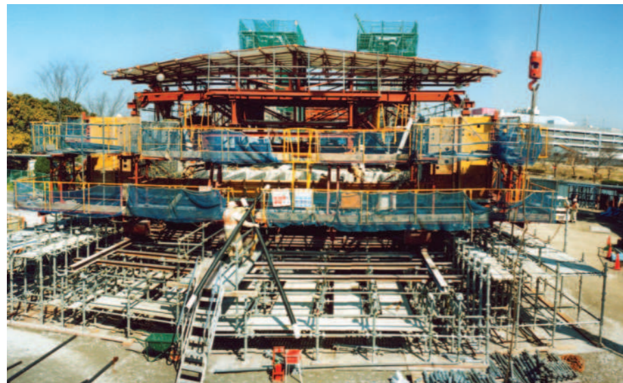
高架橋スラブ打設スライドセントル SLIDING FORM FOR OVERHEAD BRIDGE OR OVERPASS CONCRETE SLAB
