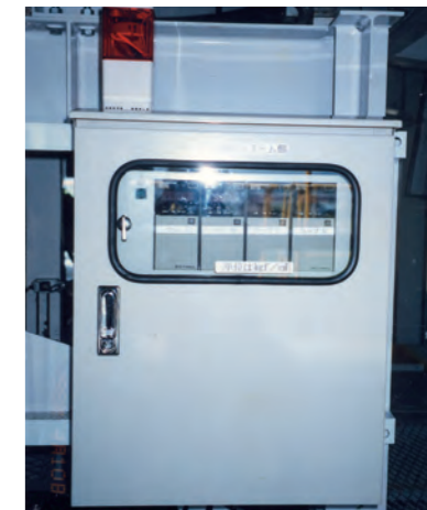
コンクリート圧力センサー制御盤 Concrete Pressure Sensor Control Box
