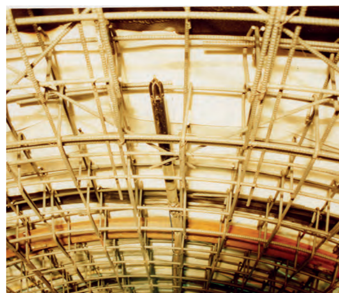
リール式引抜きバイブレータ (鉄筋区間) Reel Type (in case of there are reinforcing bars)
